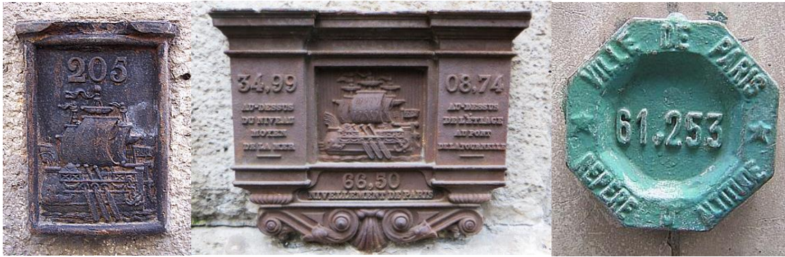
Figures 2 a, b, c : repères de nivellement de diverses époques observables dans Paris
